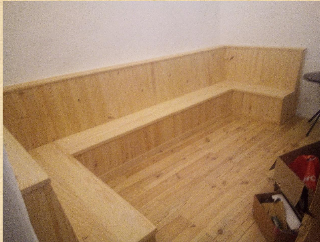
Banco-arca em formato de “U” em pinho, instalado num café-bar
