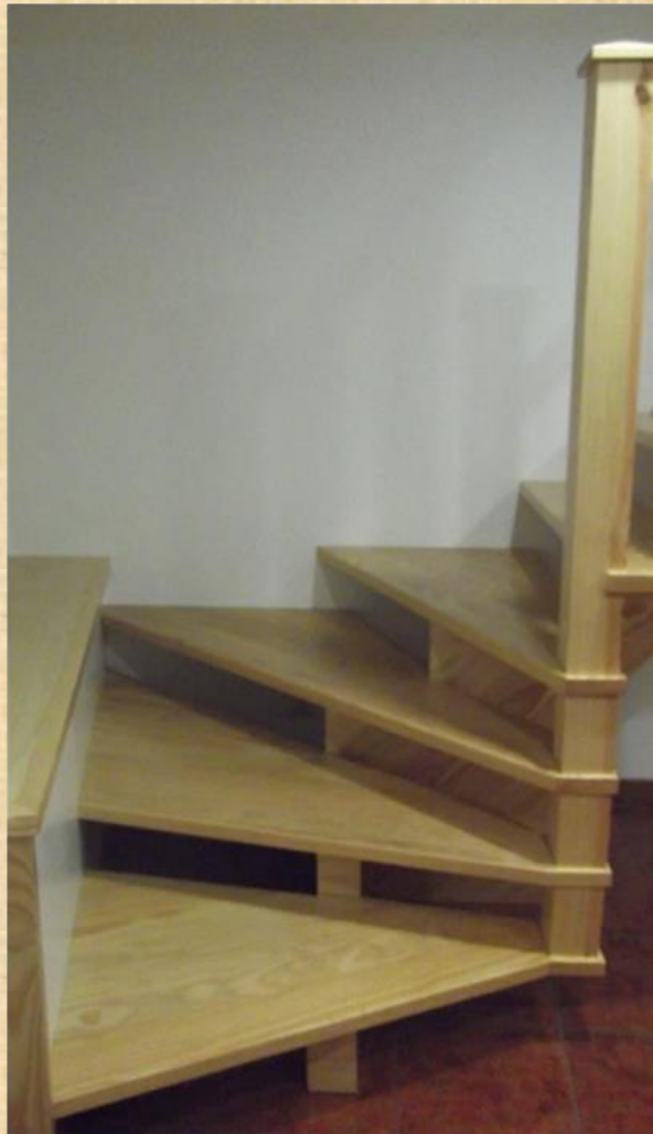
Escada em pinho bravo com terminação semicircular e com longarina única.
