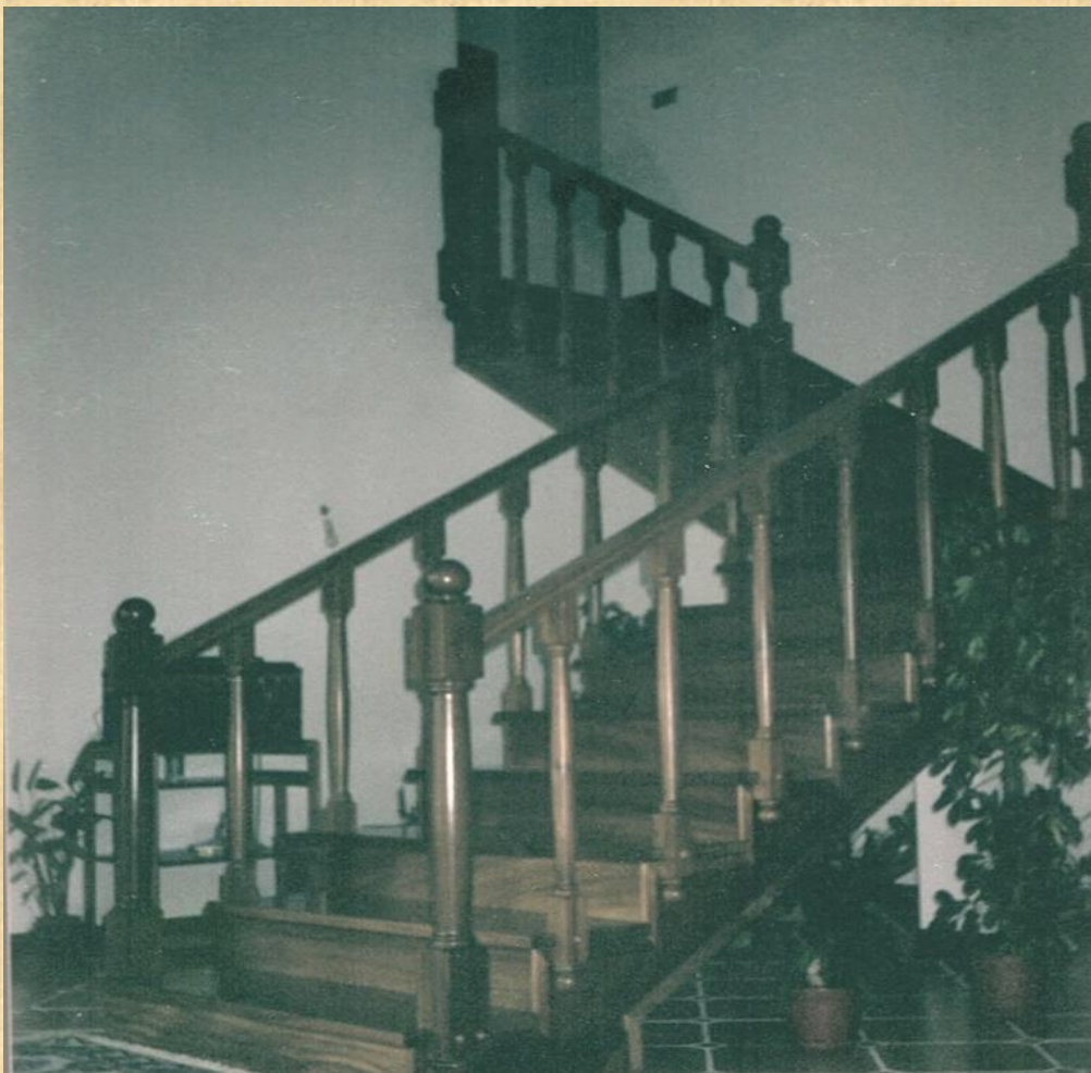
Escada em kambala escura, aberta em y.
