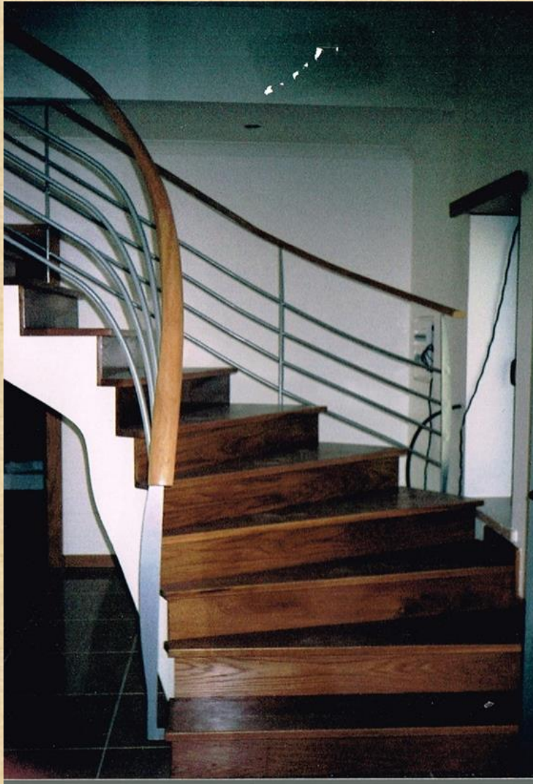
Escada semicircular em carvalho e gradeamento em inox.
