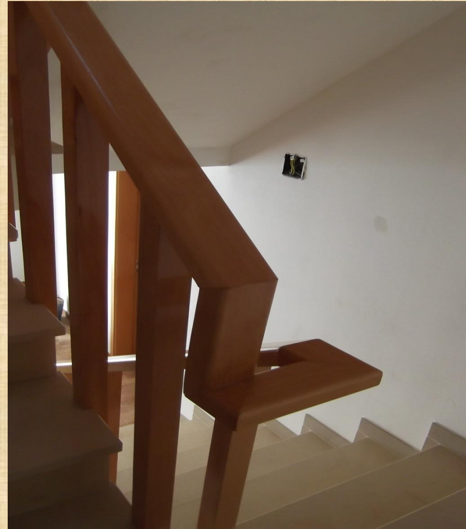
Corrimão em faia aplicado em escada de pedra
