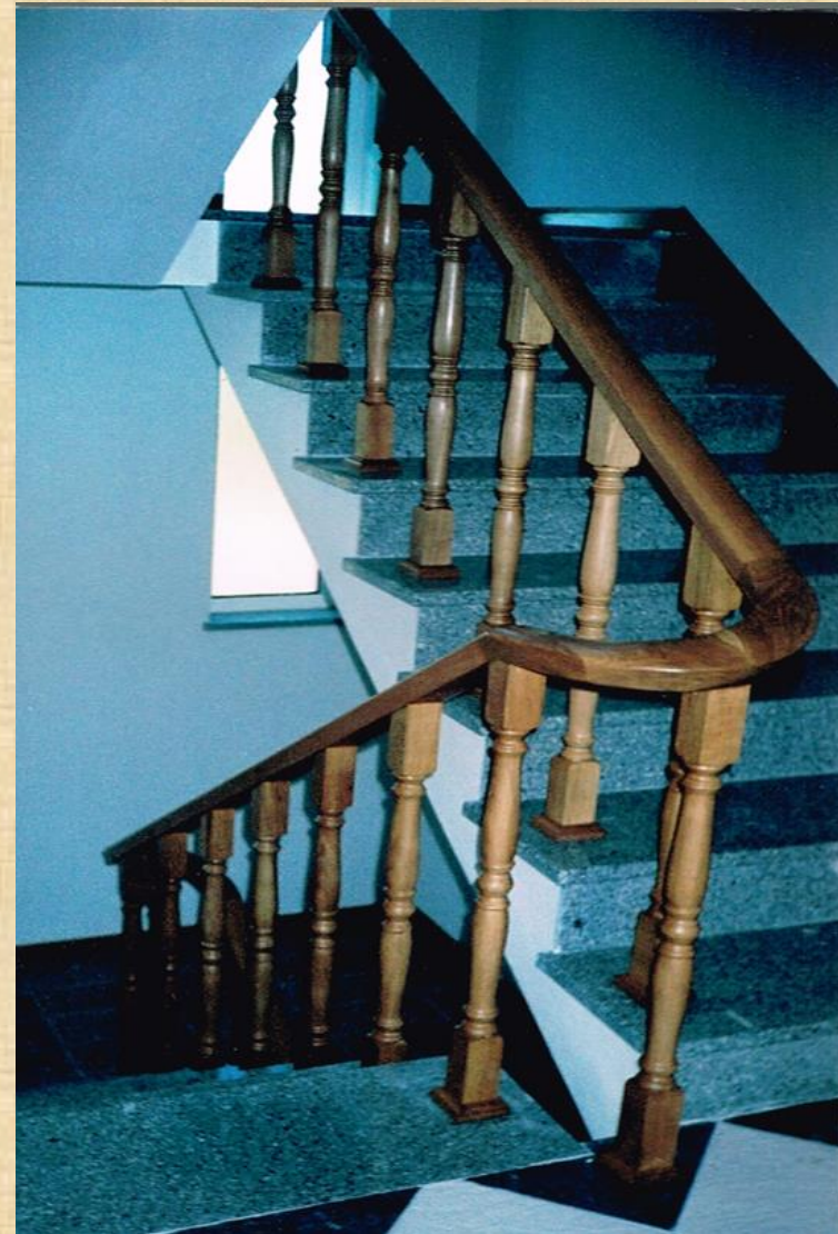
Escada em U em pedra com balaústres e corrimão em carvalho.
