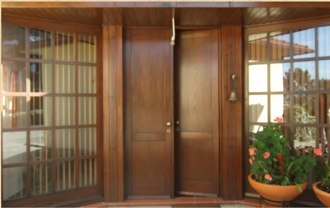
Porta de entrada em castanho bravo e contraplacado marítimo de carvalho
