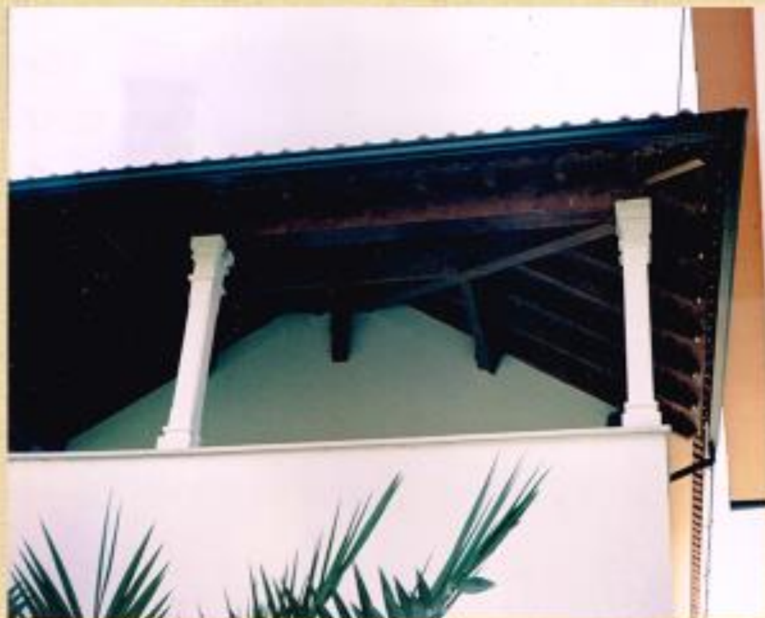
Telheiro rústico de 3 águas com estrutura em madeira
