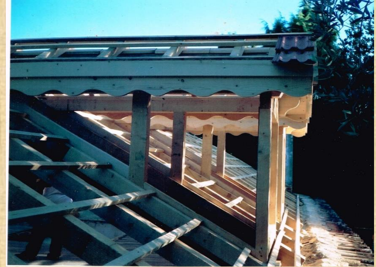
Telhado depois da reconstrução
