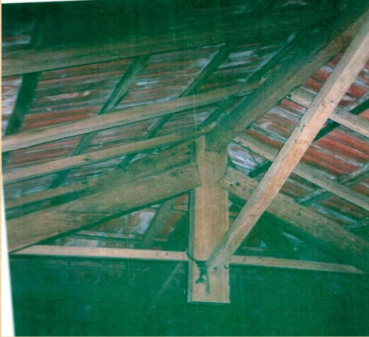
Telhado antes da reconstrução
