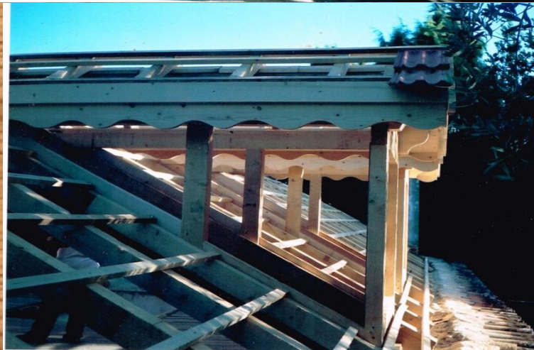
TELHADO DE SOLAR DOS ANOS 20 COM 13 ÁGUAS E DUAS CLARABÓIAS (FOTO DEPOIS DA RECONSTRUÇÃO)
