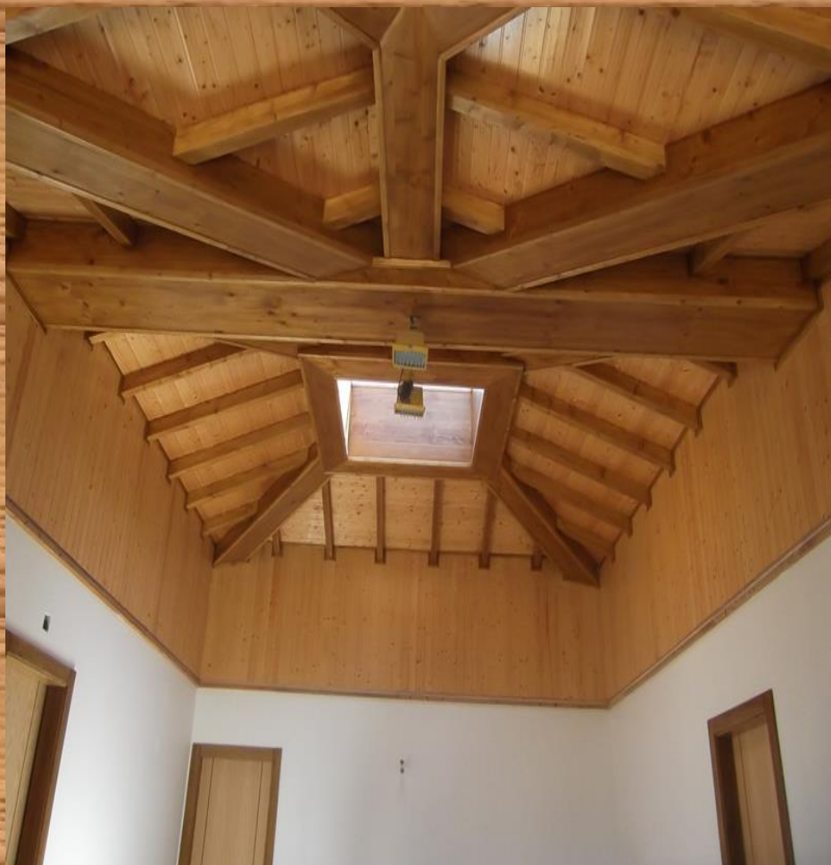
TECTO DE ÁGUAS FURTADAS EM FORMATO DE GAMELA COM ALPENDRE DE CINCO ÁGUAS, REVESTIDO A PINHO NÓRDICO COM VIGAS COM VELATURA DE CASTANHO
