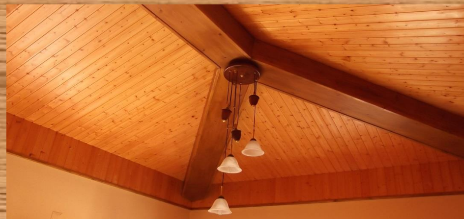
TECTOS EM PINHO BRAVO E PINHO NÓRDICO COM VIGAS COM VELATURA DE CASTANHO
